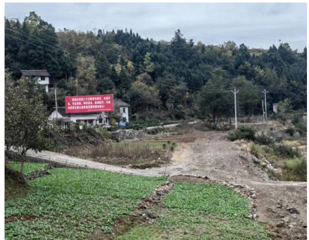
临时施工场地及临时堆场恢复
