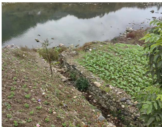
项目路面径流收集沟渠排口
