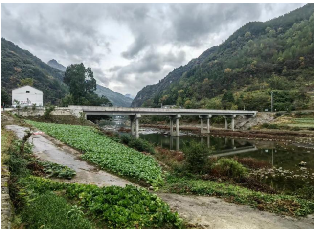
施工便道及周边恢复情况
