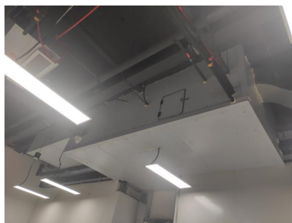
废气处理设施
