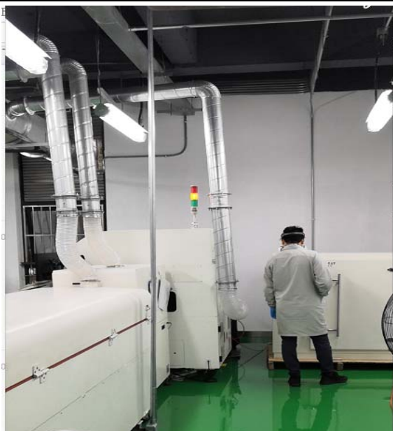
涂覆机废气收集管道
